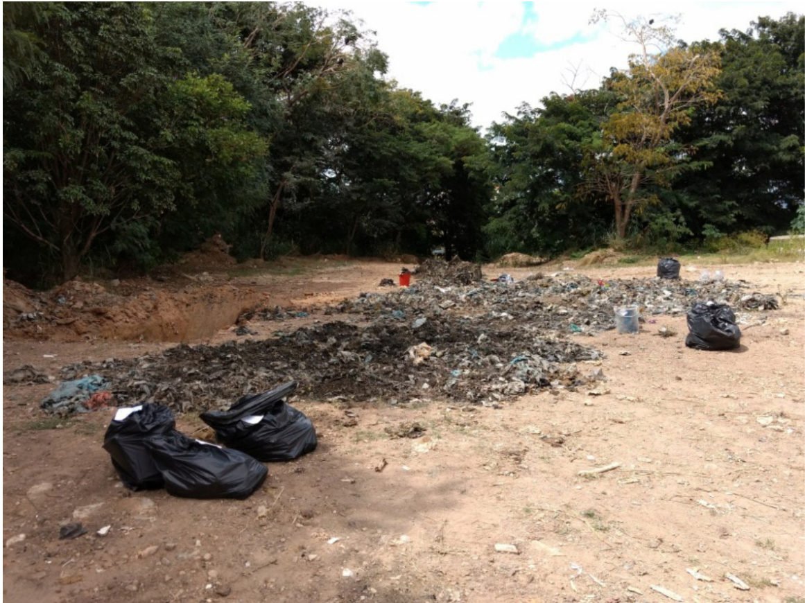
Figura 3. Resíduos escavados no Aterro Sanitário da BR-040, em Belo Horizonte: separação prévia.
