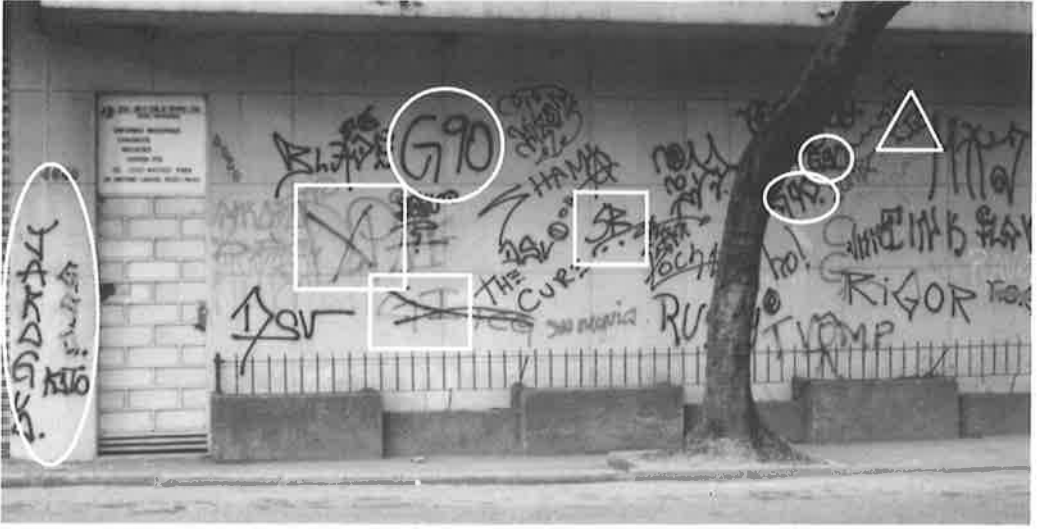
Figura 3 — Fachada na Av. Antônio Carlos, na altura do bairro Jaraguá. Assinaladas as siglas dos grupos que a ocuparam.
