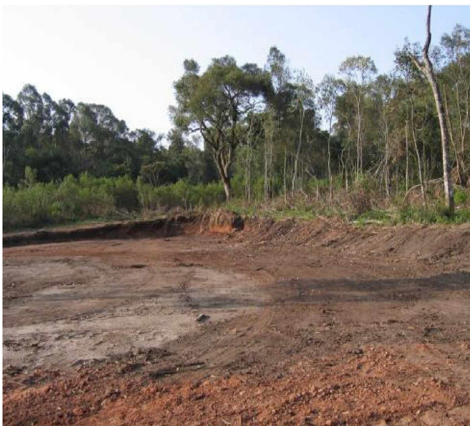
Figura 2. Espaço impactado por terraplenagem.
