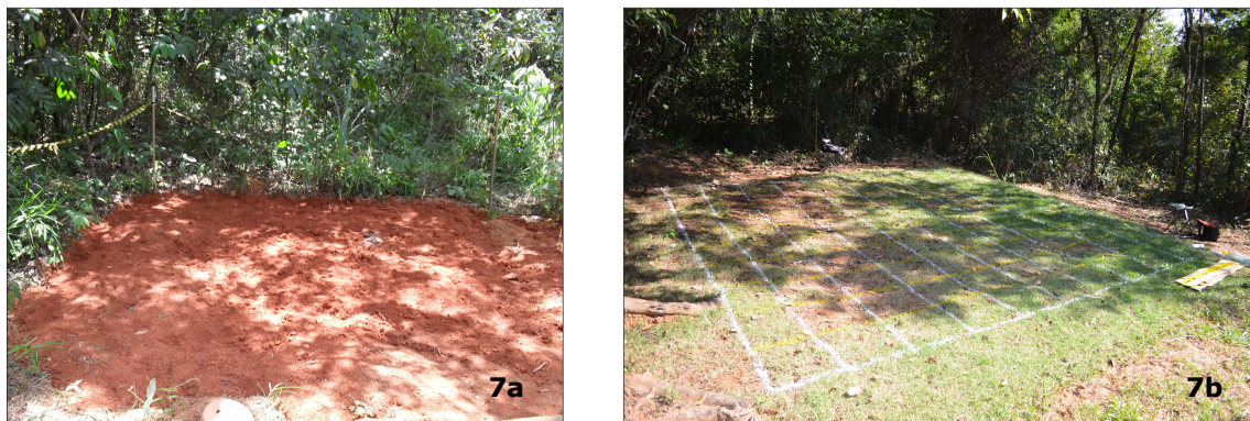
Figura 7 – a) pseudo-sítio após a preenchimento e compactação do material, b) foto após a colocação da grama e marcação das linhas de aquisição de dados, c) compactação do local.
