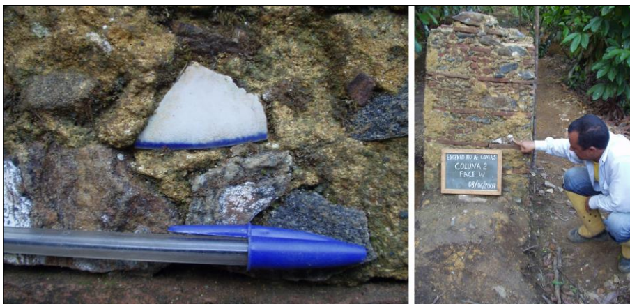
Figura 3 - Numa das colunas da face Sul, área de purgar, se indica a presença de um fragmento de faiança fina incrustado na argamassa, padrão Shell Edged, Blue Edged . Fotos: Carlos Costa, 2007.
