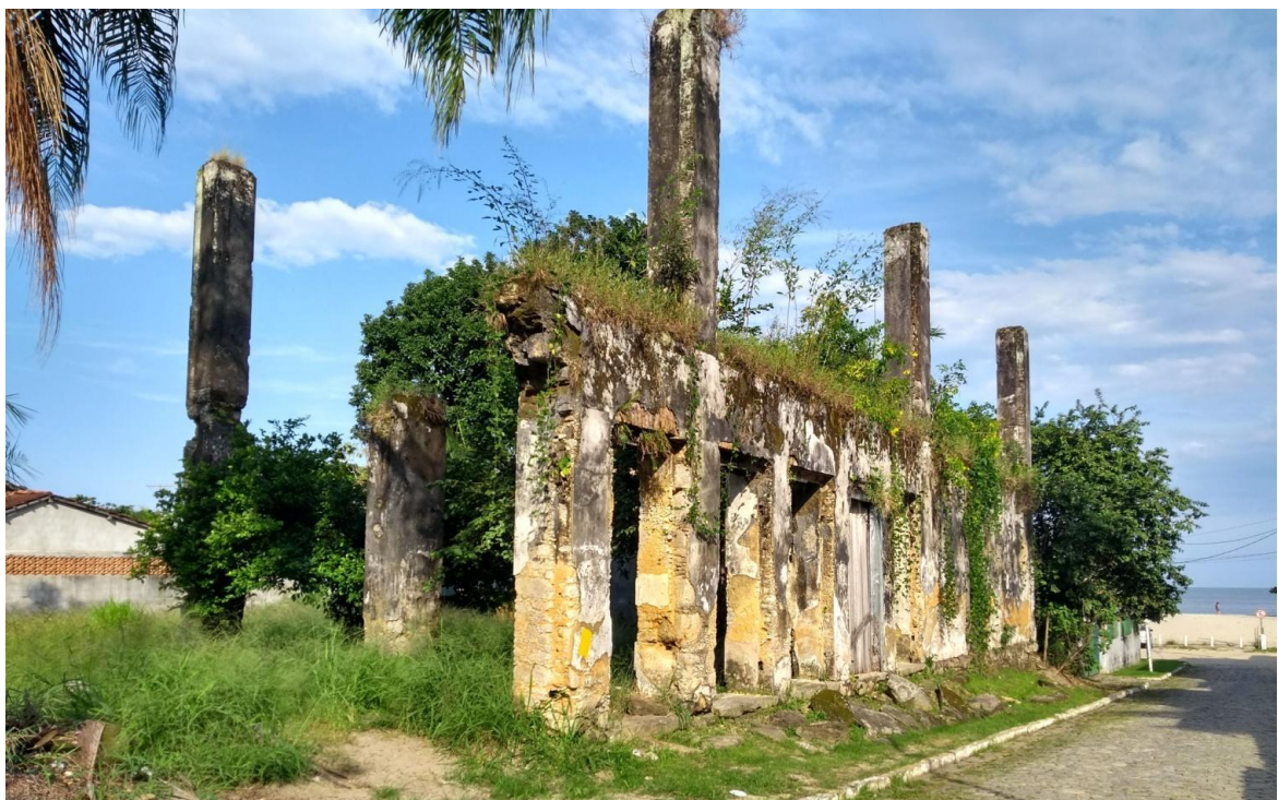
Figura 2. Ruína do sobrado da Rua do Comércio e a fundo os muros da AMAM. Foto autoral (12/05/2019).
