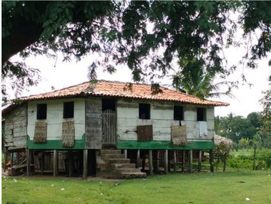
Figura 3. Uma moradia sobre palafitas na atualidade. Fotografia de Herberth Figueiredo.
