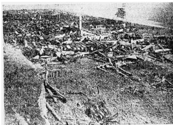
Figura 8. Escombros pós destruição
