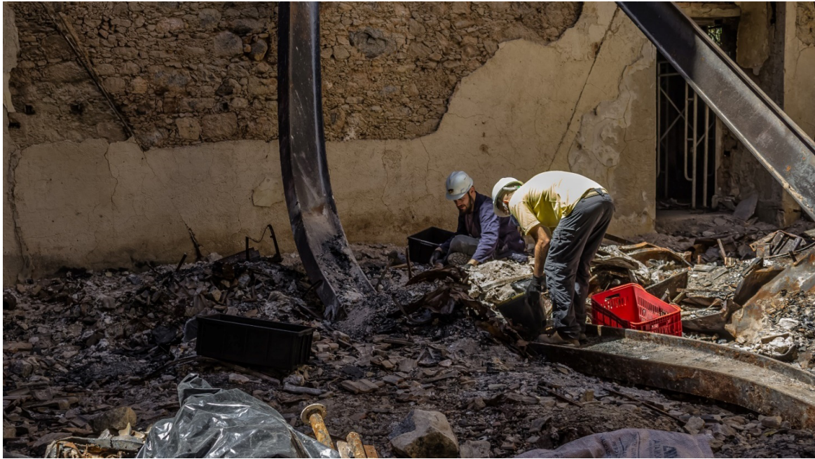
Figura 3. Viga metálica sobre os remanescentes de Sha-Amun-em-su.
