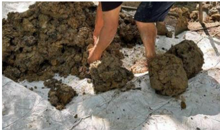
Figura 4. Preparação das bolas que serão transportadas para o galpão.
