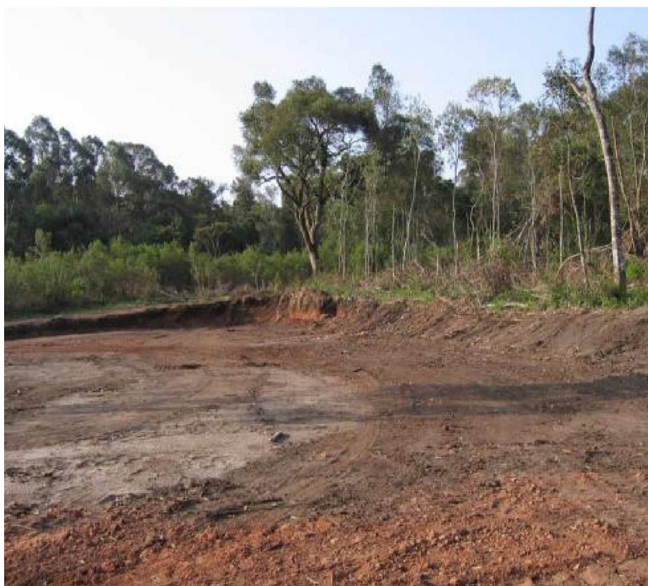
Figura 2. Espaço impactado por terraplenagem.
